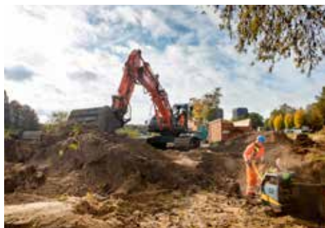
Medewerkers Gebr. Coremans aan het werk op locatie
