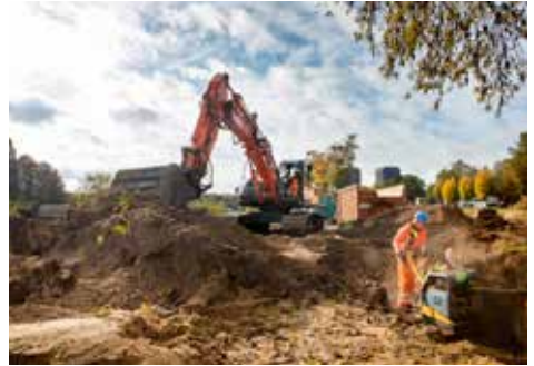
Medewerkers Gebr. Coremans aan het werk op locatie
